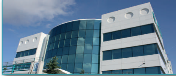
Arfen İnşaat A.Ş. / İSTANBUL
